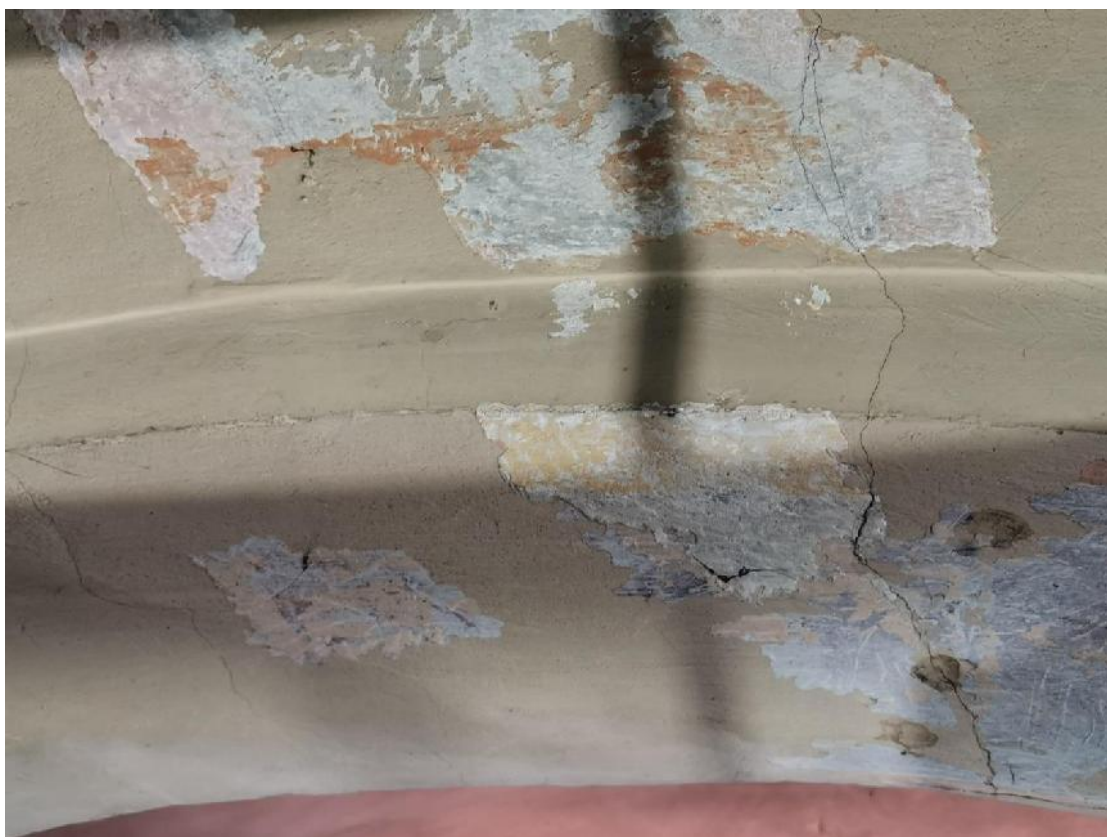
15. I - Koplyčios įėjimo angokraščio XVIII a. tapyba. Tapyba uždažyta, tinko įtrūkimai, 2023.
