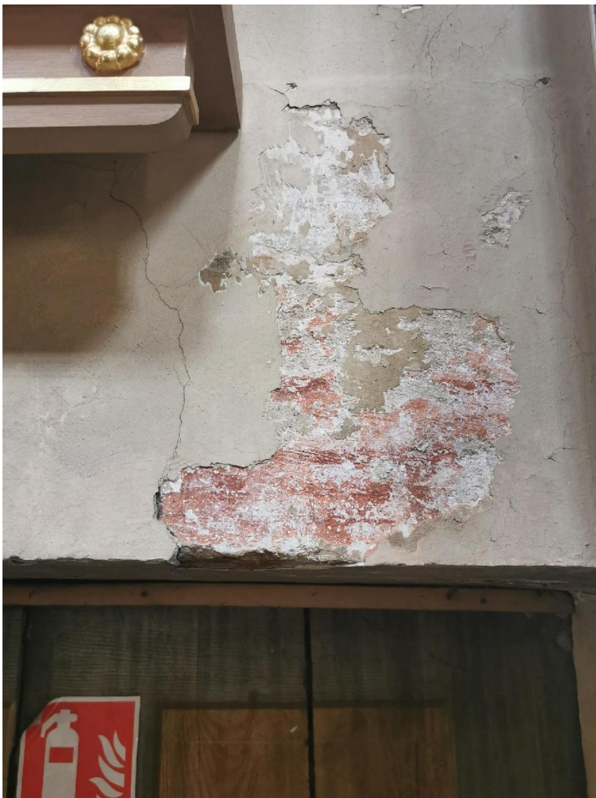
3. A - Pirminė XVIII a. tapyba prie durų presbiterijos šiaurės sienoje, detalė. Uždažymai, įtrūkimai, pažeistas tapybos paviršius trupa, 2023.
