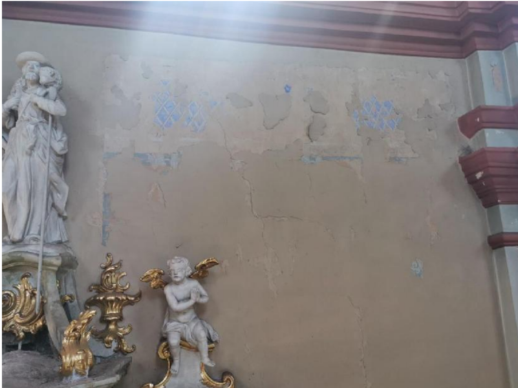
5. C - Ornamentinės XIX – XX a. pr. tapybos fragmentas presbiterijos šiaurės sienos viršuje. Vėlesni uždažymo sluoksniai lupasi, tapyba trupanti, yra tinko įtrūkimų, 2023.
