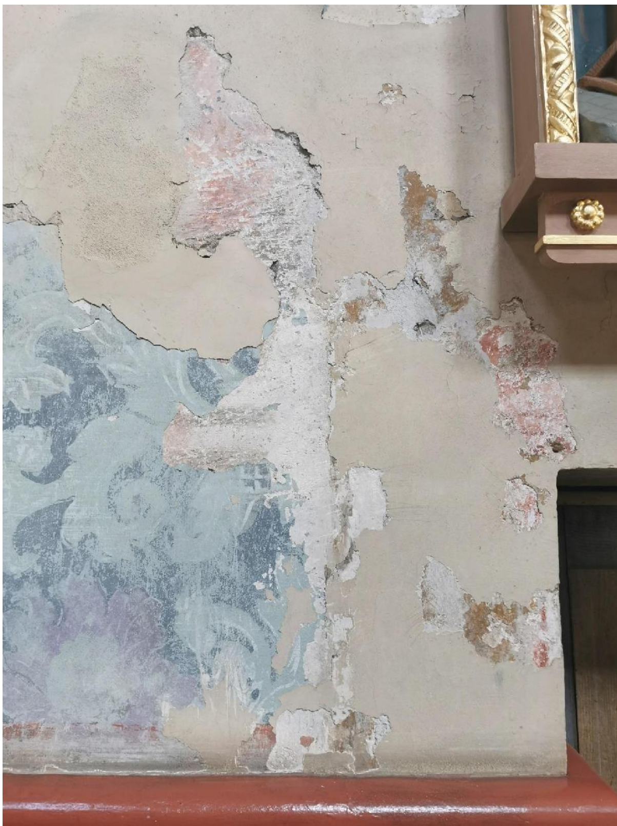
2. A - Pirminė XVIII a. tapyba prie durų presbiterijos šiaurės sienoje, detalė. Atodangose pirminė autentiška tapyba pažeista mechaniškai ir pradengta XIX a. sienų apmušalų imitacija, 2023.
