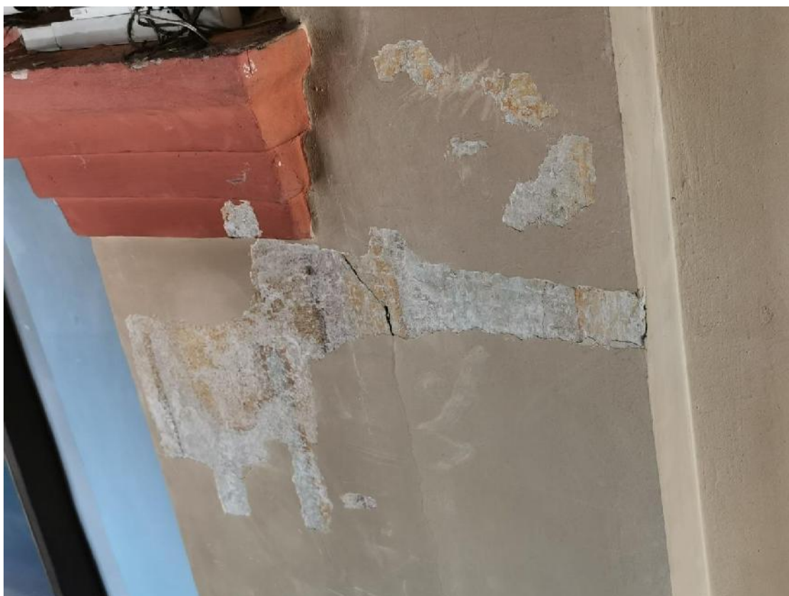
14. I - Koplyčios įėjimo angokraščio XVIII a. tapyba. Tapyba uždažyta, tinko įtrūkimai, 2023.
