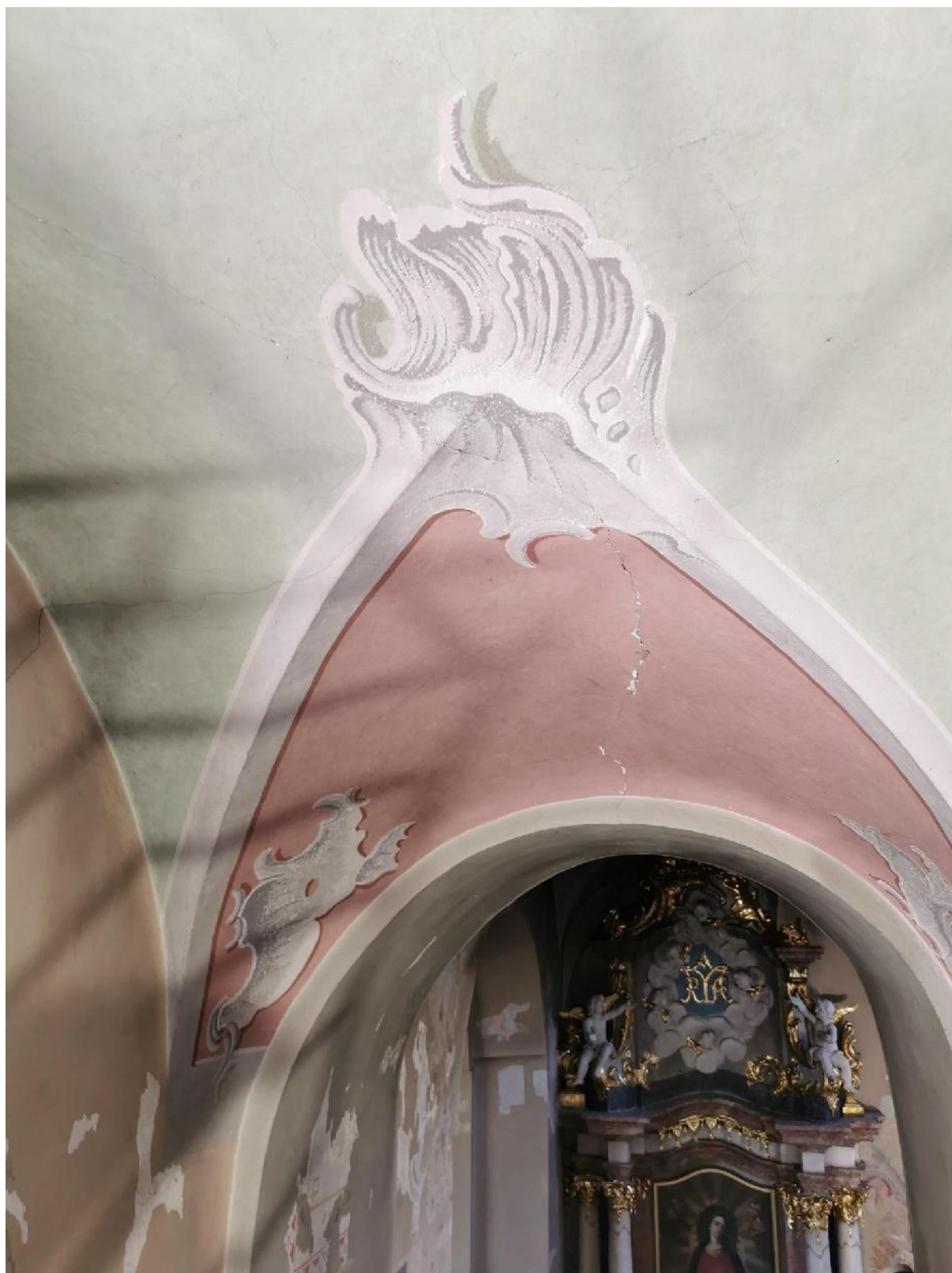
23. K – pietinės navos skliautų tapyba, užtapyta, tinko įtrūkimai, 2023.
